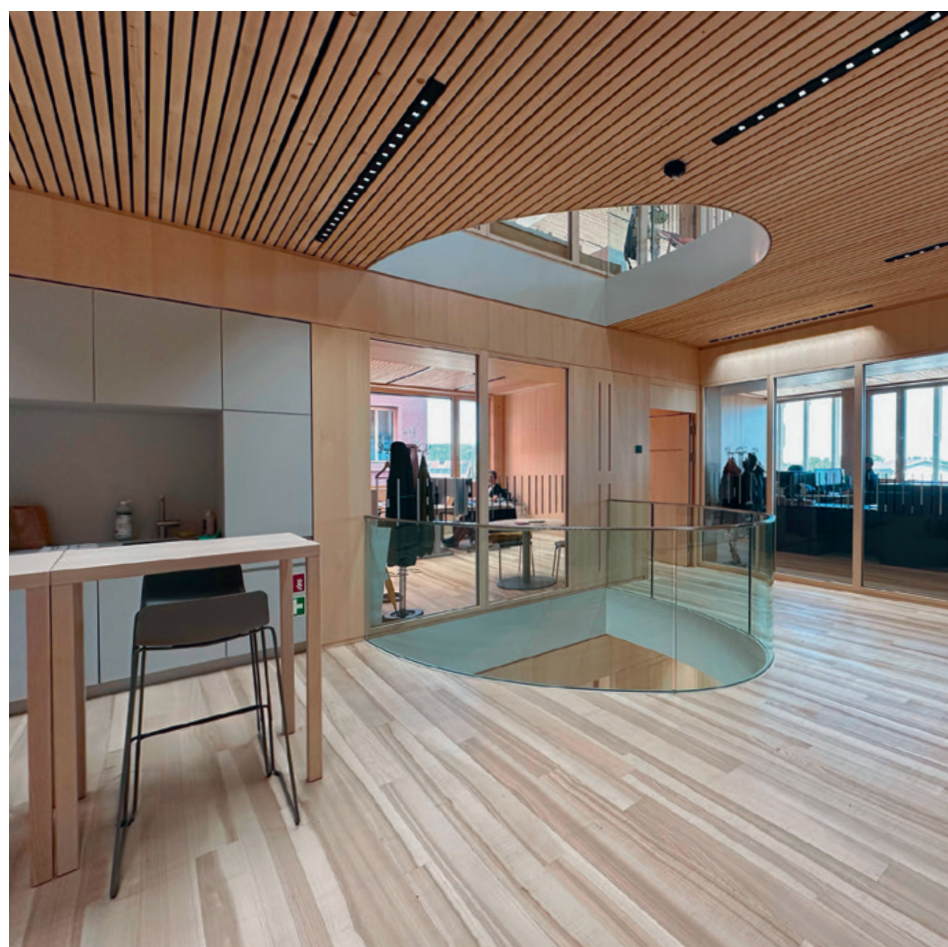
Modernes Verwaltungsgebäude mit Fußbodenheizung und -kühlung unter sägerauem Holzboden
